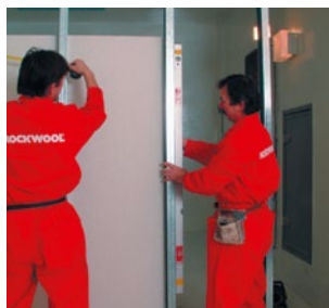
Montáž kovových nosných profilů (obr. 16)
