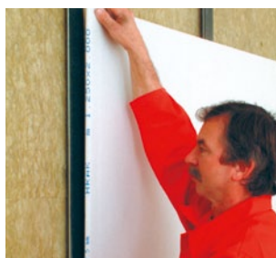
Montáž sádkartonových desek (obr. 20)
