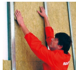
Vyplnění příčky akuzolací (obr. 17)
