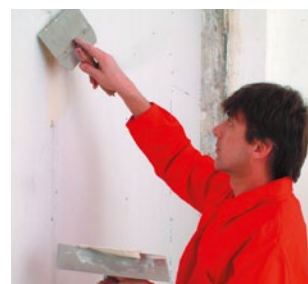
Vyplnění spár mezi deskami tmelem (obr. 21)
