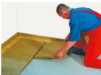
Pokládka izolace Steprock HD (obr. 17)
