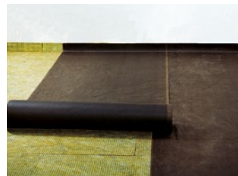
Pokládka hydroizolační vrstvy (obr. 5)
