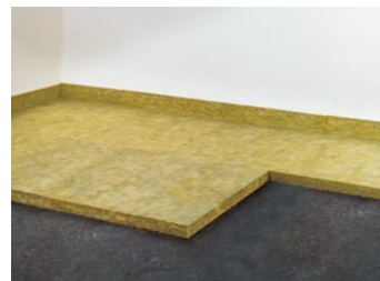
Pokládka desek Steprock ND (obr. 4)
