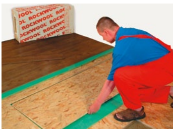
Pokládka druhé roznášecí vrstvy (obr. 19)
