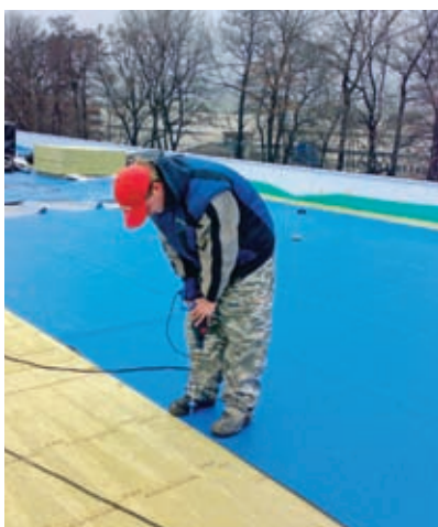
Kotvení povlakové hydroizolace (obr. 10)
