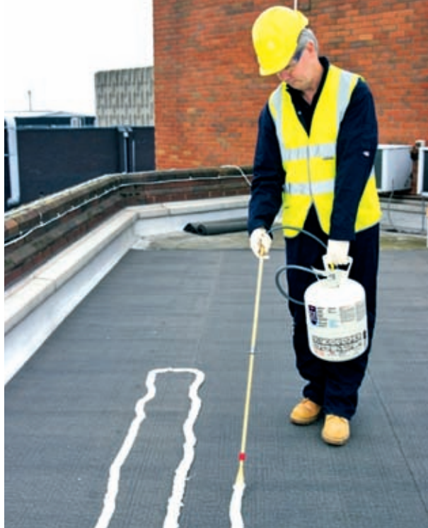
Aplikace lepidla INSTA-STIK (Dow Chemical) (obr. 51)
