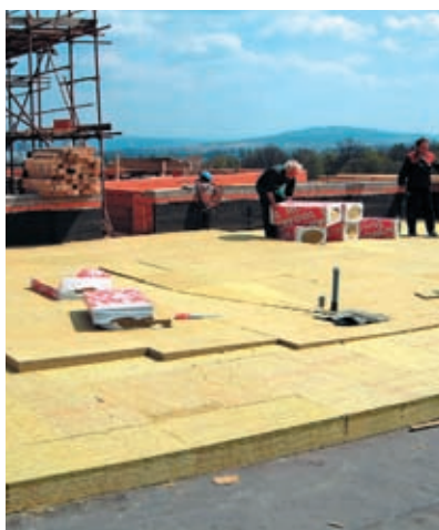
Montáž spádového systému (obr. 11)
