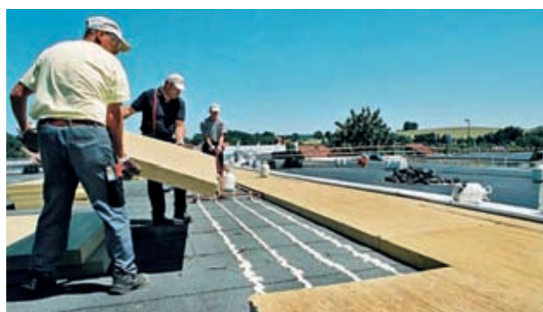
Kladení desek do lepidla INSTA-STIK (Dow Chemical) (obr. 52)
