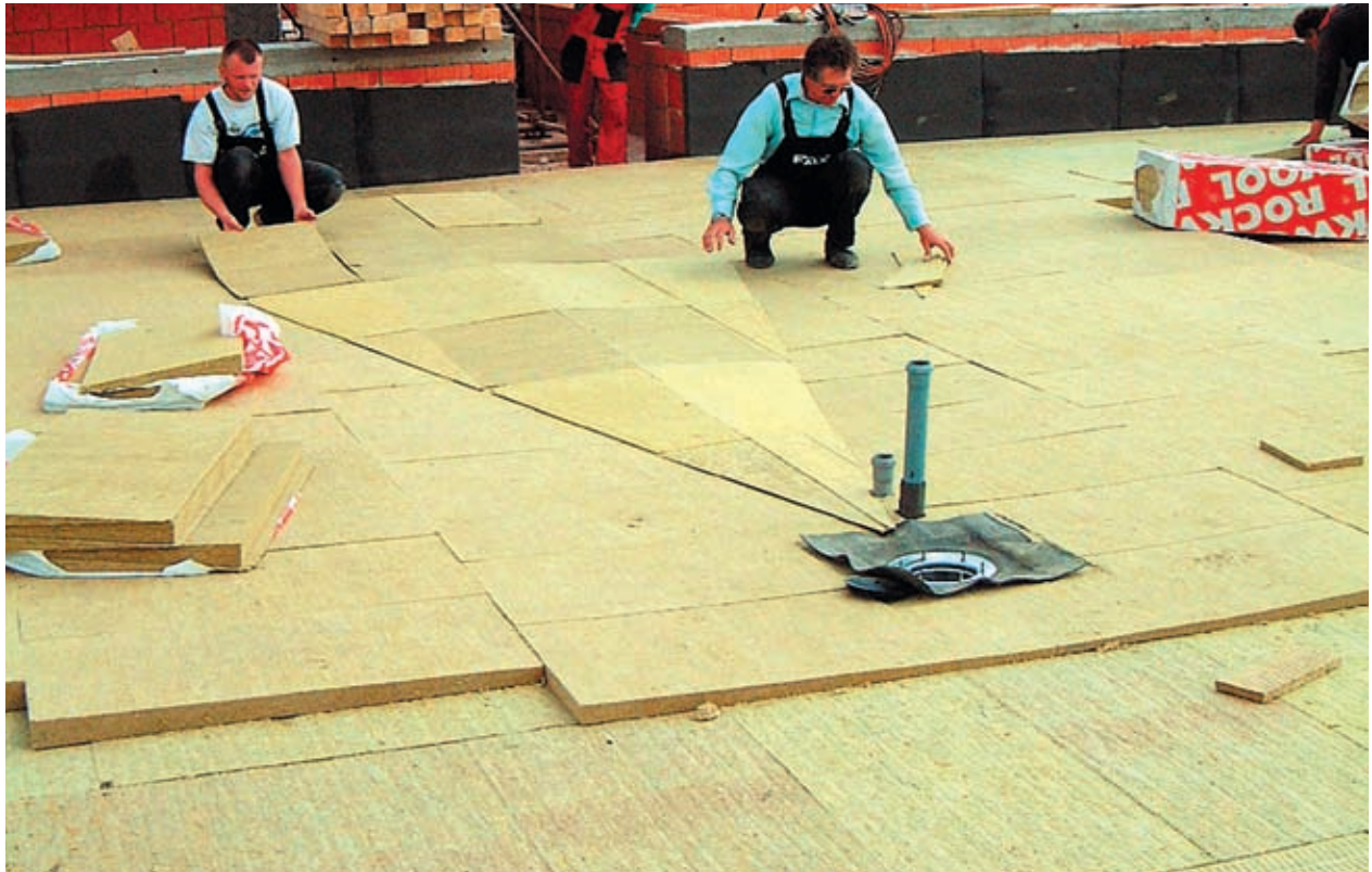
Pokládka desek ROCKFALL do úžlabí na spádových deskách (obr. 36)
