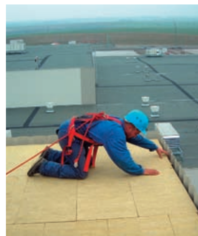
Montáž tepelněizolačního souvrství u atiky (obr. 12)
