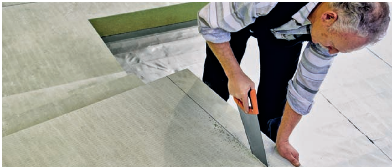
Řezání desek Megarock MAX – ani vrchní cementová vrstva nepředstavuje překážku pro pilu (obr. 53)
