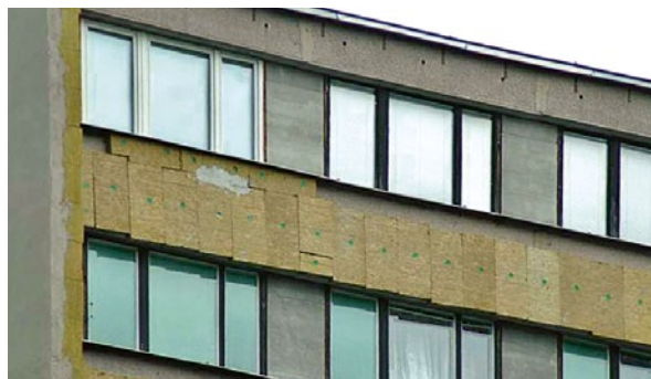
Chybné řešení pokládky desek (obr. 19)
