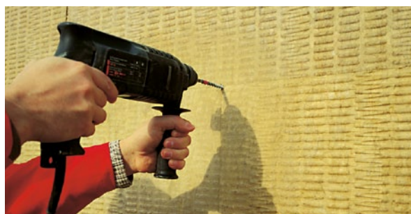
Vrtání otvoru pro hmoždinku (obr. 28)
