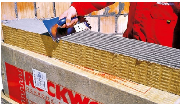
Nanášení lepicí hmoty u desek Fasrock LL (obr. 13)
