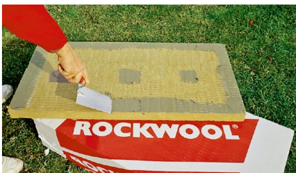
Lehké přestěrkování desek Frontrock MAX E a Fasrock v místě aplikace lepidla (obr. 14)
