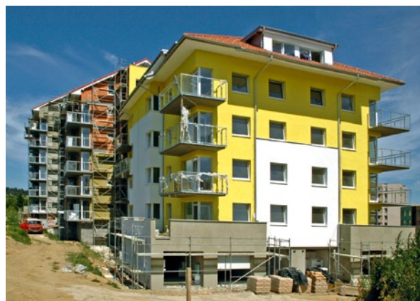
Příklad realizace zateplení bytového domu s použitím desek Frontrock MAX E (obr. 37)
