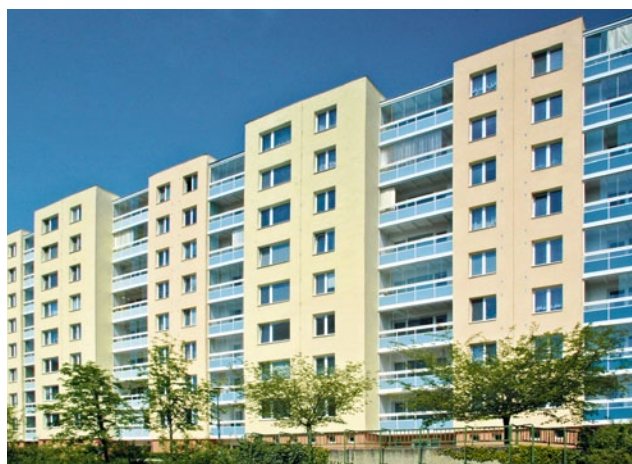
Příklady fasád zateplených pomocí desek ROCKWOOL (obr. 9, 10)
