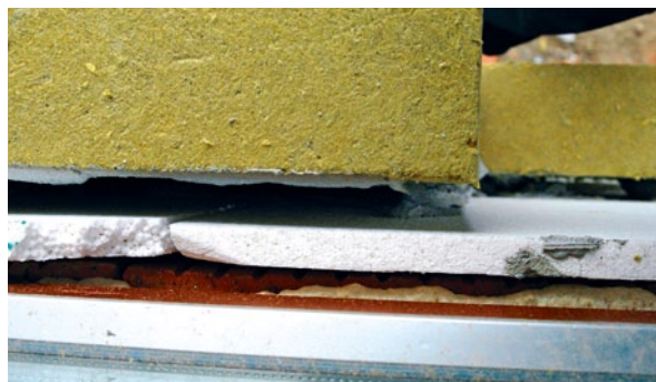
Nevhodná aplikace desek – zakázané tzv. podlepování (obr. 17)
