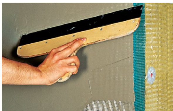
Vyhlazení krycí hmoty po aplikaci výztužné síťoviny (obr. 34)
