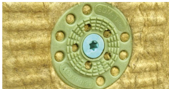
Ukázka správně zapuštěné hmoždinky (obr. 30)
