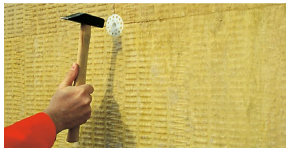
Upevnění talířové hmoždinky (obr. 29)
