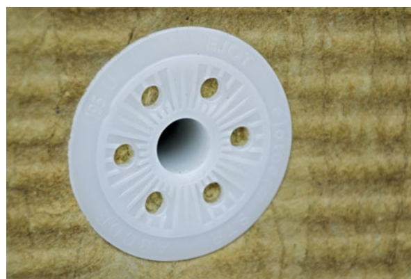
Správně osazená mechanická kotva (obr. 36)
