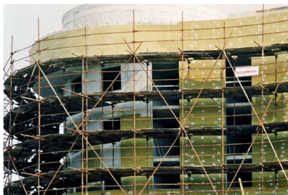
Aplikace Fasrock LL na oblou stěnu (obr. 39)
