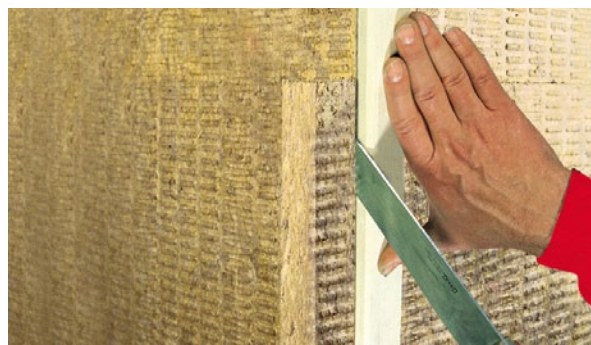
Odstranění přebytečné izolace v rohu (obr. 25)
