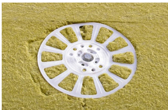
Ukotvení lamel Fasrock LL talířovou hmoždinkou (obr. 33)
